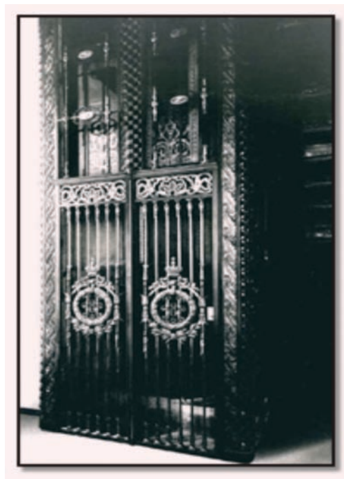
Un ascensor Otis en el Palacio Nicolavaski del Kremlin en Moscú.
